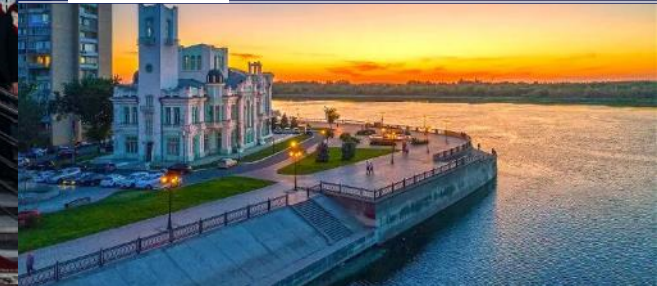
Реконструкция Волжской набережной к 450-летию Астрахани ▶
