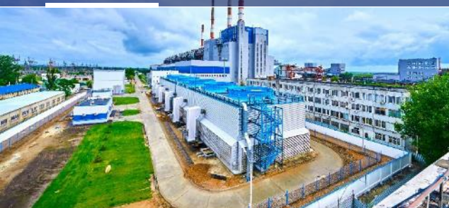
Строительство 9-го энергоблока Новочеркасской ГРЭС ▶
